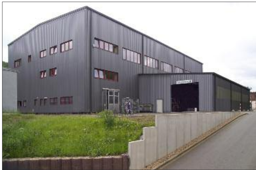
Die Firma Graubmann hat im Jahr 2000 eine Industriehalle übernommen. Seitdem investierte das Unternehmen am Standort Schwarzenberg in neue Produktionsgebäude.
