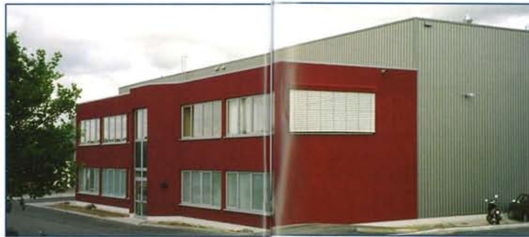
Das Unternehmen Oberflächentechnik Uwe Graubmann Schwarzenberg hat in Reinsdorf bei Zwickau eine Betriebsstätte zur KTL-Beschichtung errichtet. Fotos: Frank Reichel
